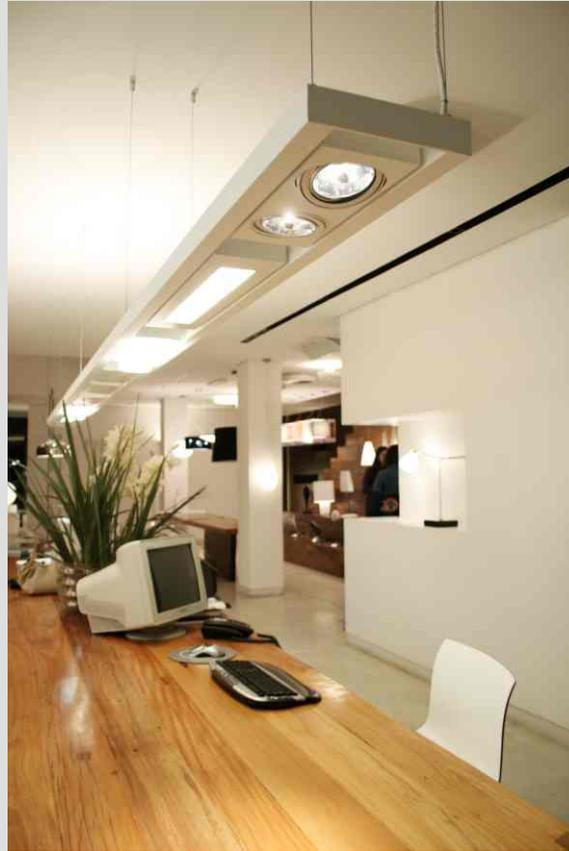
**Especificação:** Consiste em módulos de perfil de alumínio, independentes e dispostos no suporte que funciona como um trilho. A alimentação de energia se dá individualmente, possibilitando com isto a movimentação ou troca dos módulos, de acordo com a necessidade de sua aplicação. Possibilita vários tipos de montagem para.
